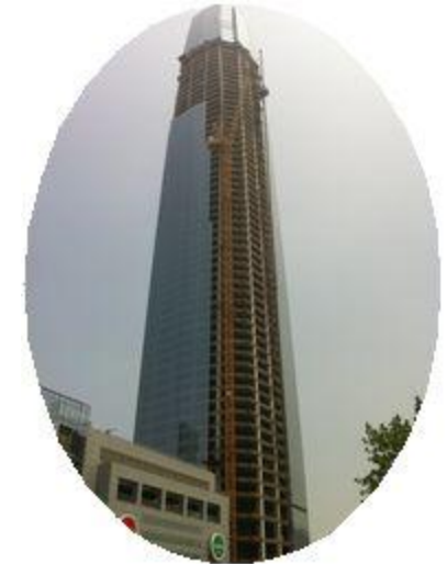
建設中のCostanera Center
