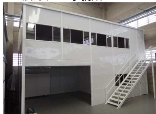
<1F:倉庫、2F:事務所>
