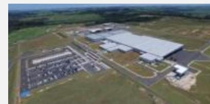
「シンプル＆スリム」「フレキシブル」をキーワードに、日本の工場でも導入を進めている革新的生産技術を導入。その結果、エンジン工場の主要工程（鋳造・機械加工・組み付け）を一つの建屋に集約し、コンパクトで需要変動に強い工場が完成。
