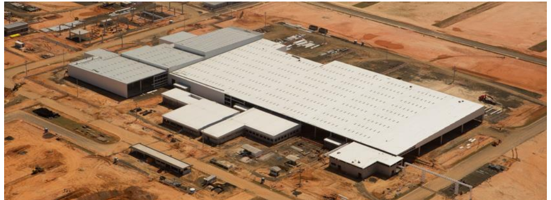
(2)エンジン工場の建設(Porto Feliz市)
