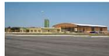
Instalações Administrativas e Galpão
