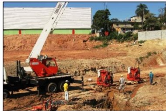
ジェットグラウト施工状況
