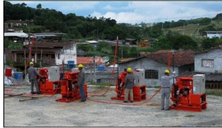
薬液注入 施工状況
