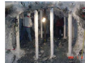
地下の凍土掘削
