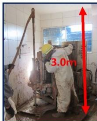
建物内でのジェットグラウト施工
