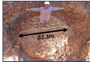
ジェットグラウト施工出来形(φ2.3m)
