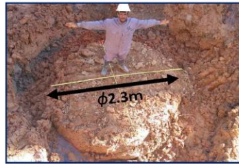
ジェットグラウト施工出来形(φ2.3m)
