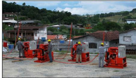
薬液注入 施工状況
