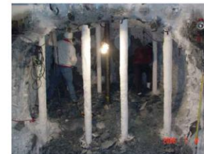
地下の凍土掘削
