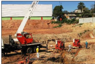
ジェットグラウト施工状況
