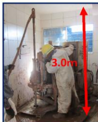
建物内でのジェットグラウト施工
