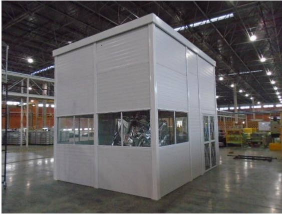
工場内での検査室
